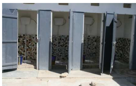
Cuatro de los nueve servicios contruidos
